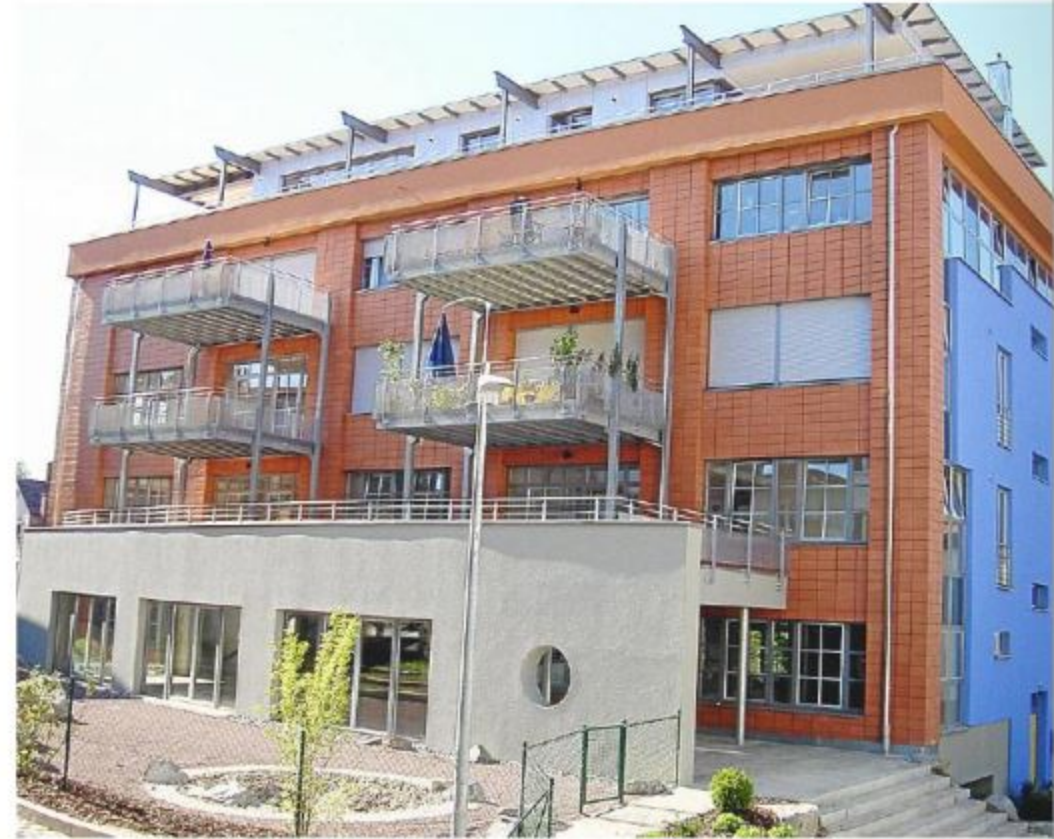
Ein Teil der „Feil’schen Stuhlfabrik“ in Marbach wurde komplett saniert und in Wohn- und Bürolofts umfunktioniert.
